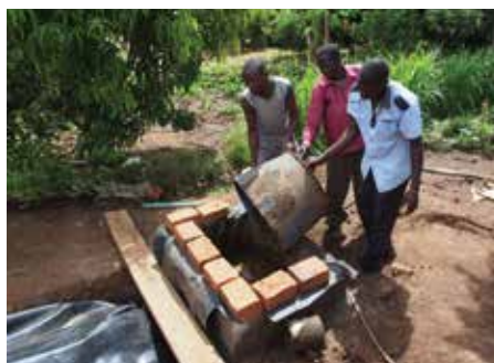
Colocação de esterco em um digestor de biogás.
